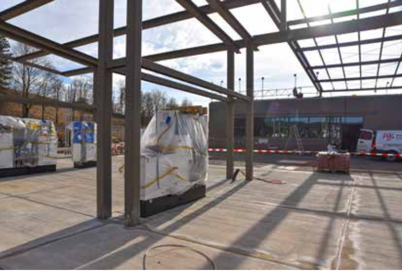
Foto Eder. Die Tankstellenbaustelle an der B16
